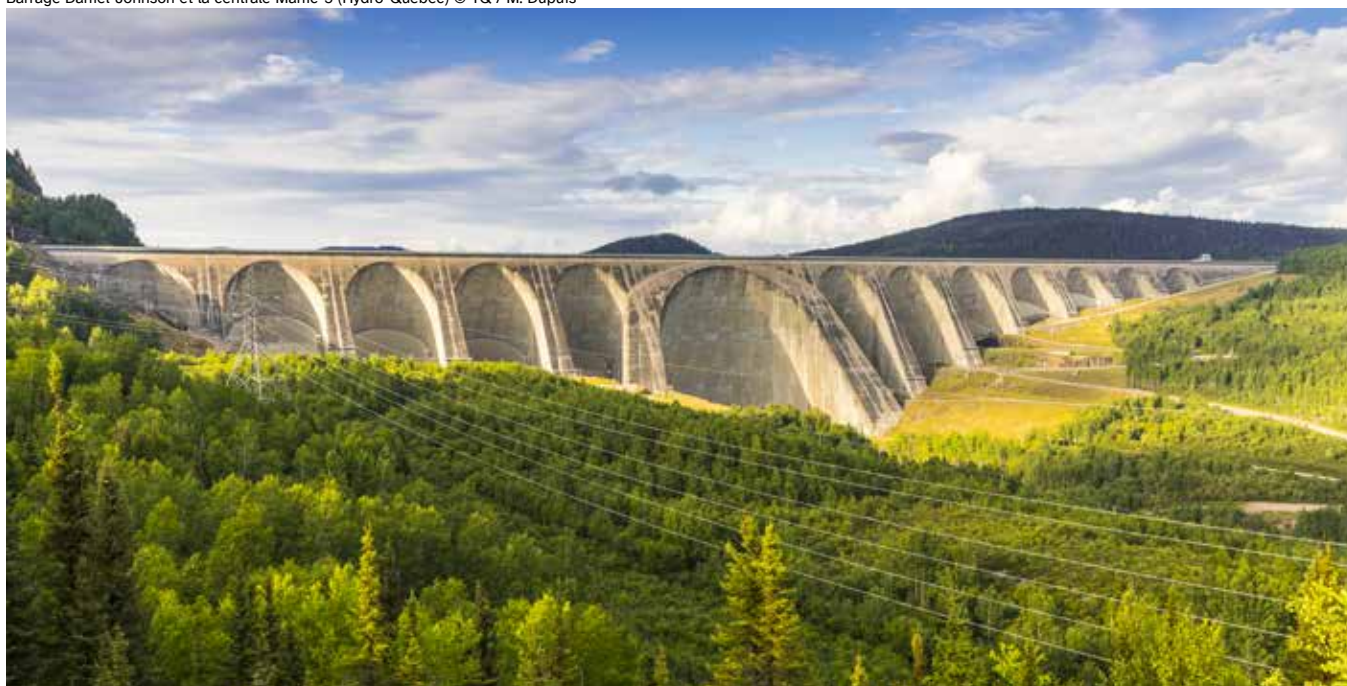
Barrage Daniel-Johnson et la centrale Manic-5 (Hydro-Québec) © TQ / M. Dupuis
